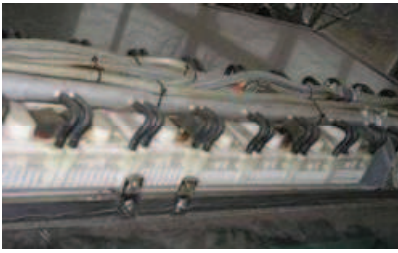
Figure 2-25. Batteries Ni-Cd installées sur le microbus du LTE
